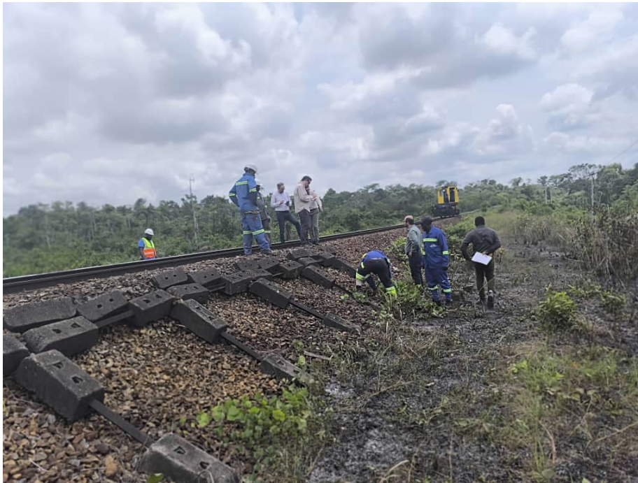
Rechargement du remblai du PK 18+150
