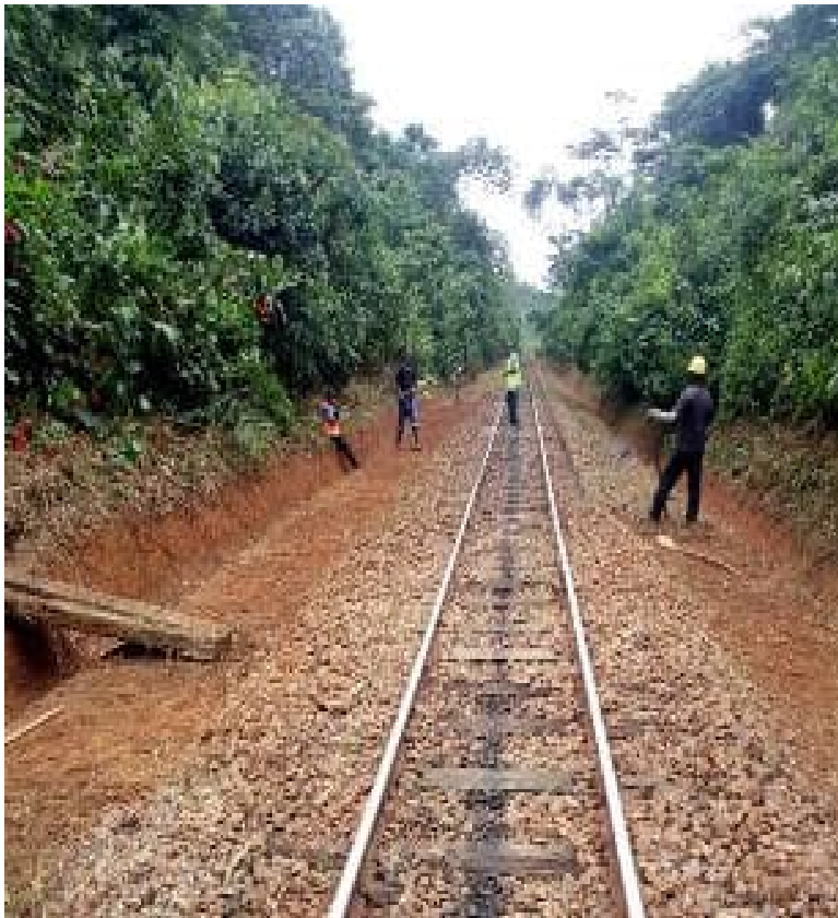
Voie ferrée existante
